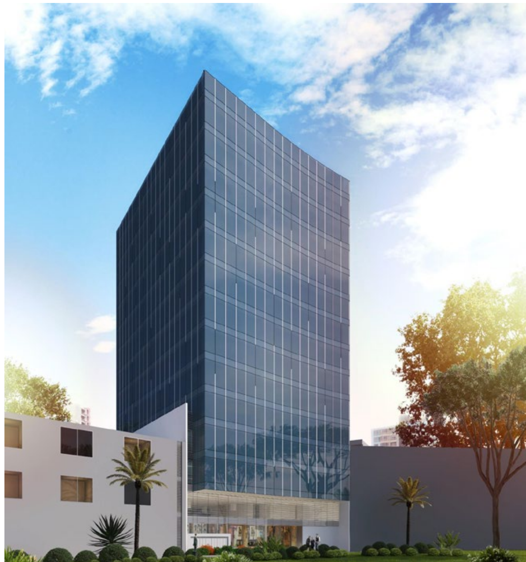
Fachada - Parque Augusto Tamayo
