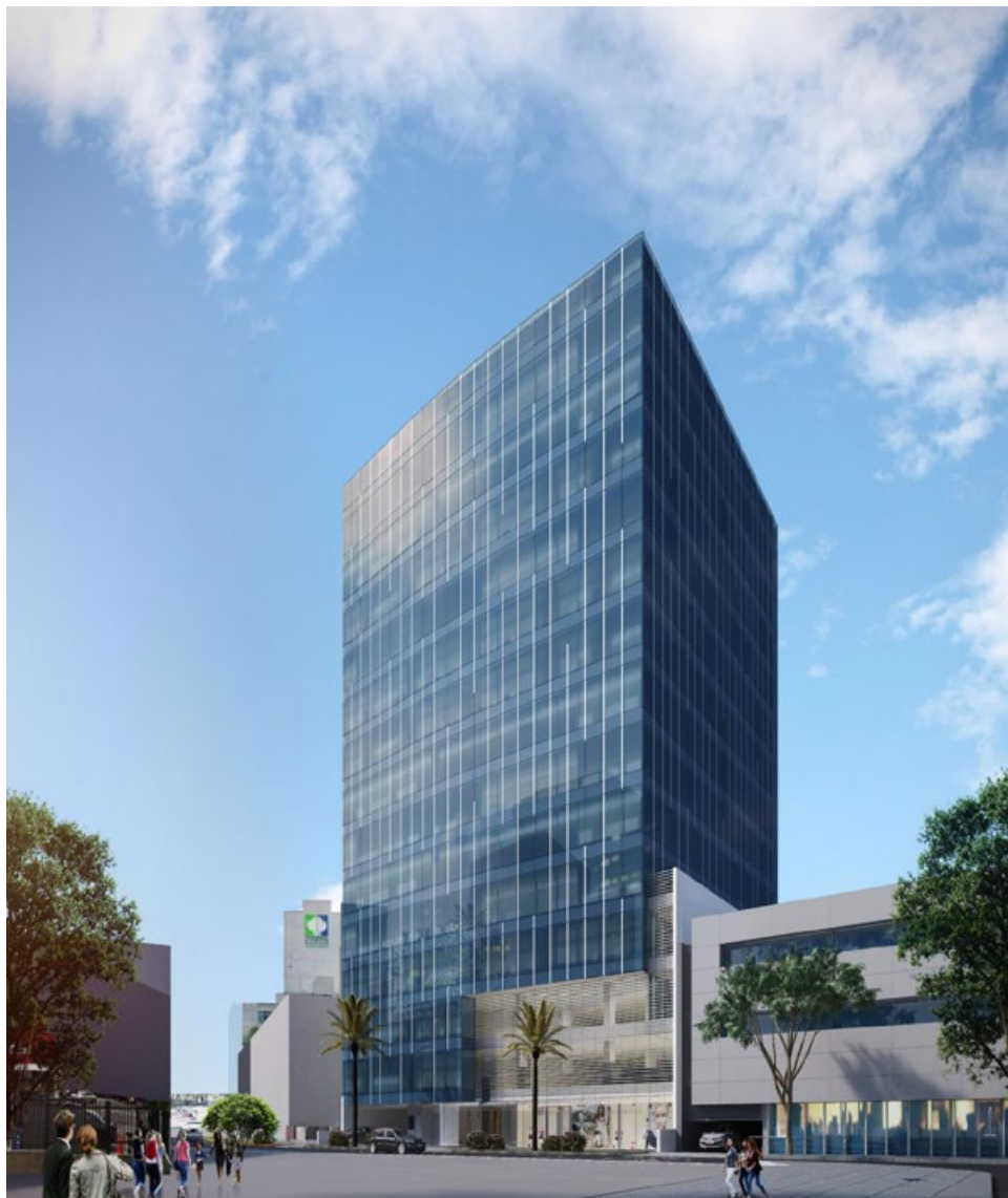
Fachada - Av. Augusto Tamayo
